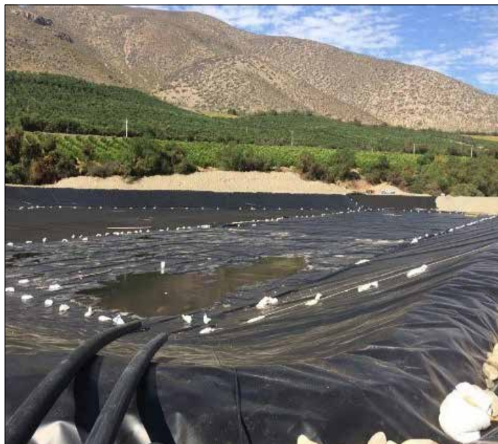
Fundo La Greda, en Monte Patria, tranques de agua cubiertos con membranas sintéticas para evitar las pérdidas por infiltración, ahorrando hasta un 40% de agua.
